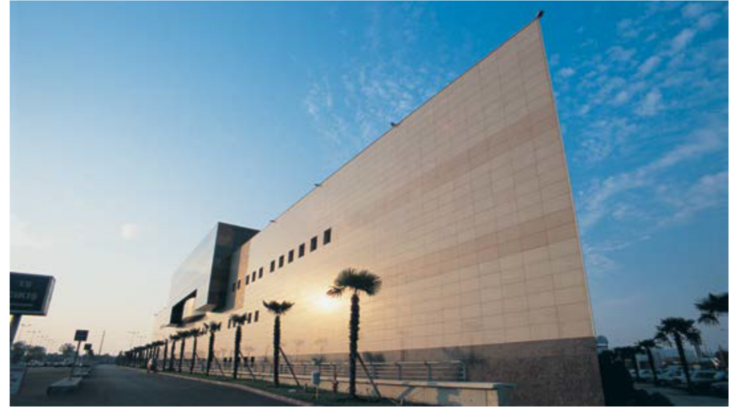
Asmerkez Alışveriş Merkezi / Bursa — 60x120 Signus Parlak & 60x120 Pega Parlak / Gizli Sistem Asmerkez Mall / Bursa — 24"x48" Signus Polished & 24"x48" Pega Polished / Invisible System Mimar — Architect: Mithat Kirayoğlu
